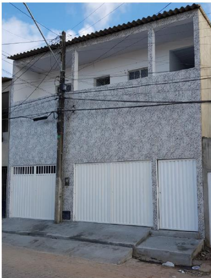
Imóvel localizado na Rua José Macário, nº 13, Jacintinho, Maceió/AL
